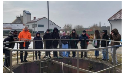
Besuch der Kläranlage Neuruppin
